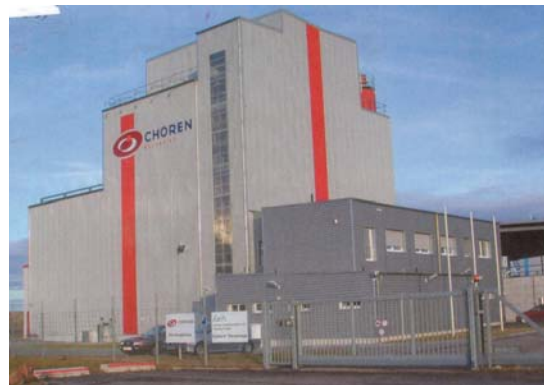
図 22 Die Chorán Industries GmbH のバイオマスプラント
