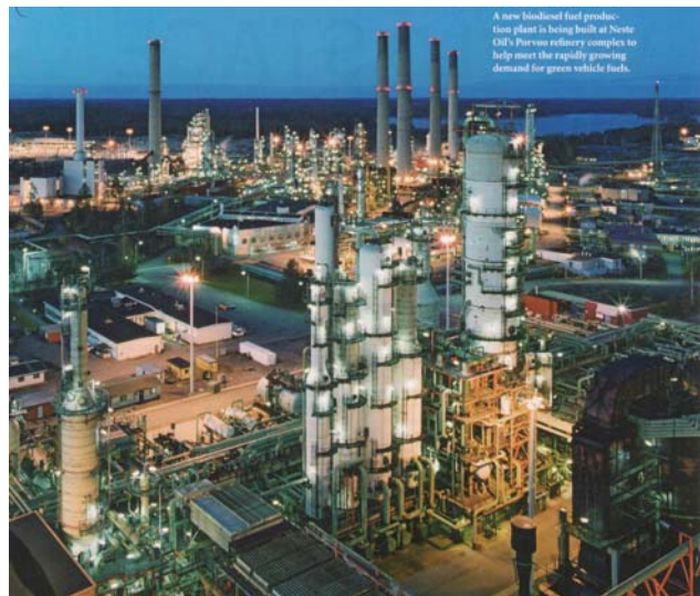
図 24 天然油→バイオディーゼルオイル製造プラント
